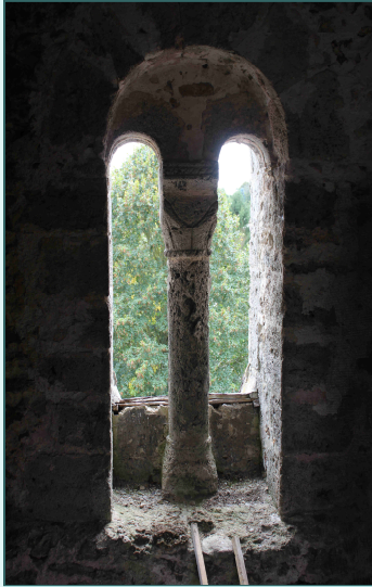
baie géminée sud
