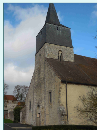
vue du sud-ouest
