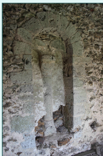
baie géminée nord
